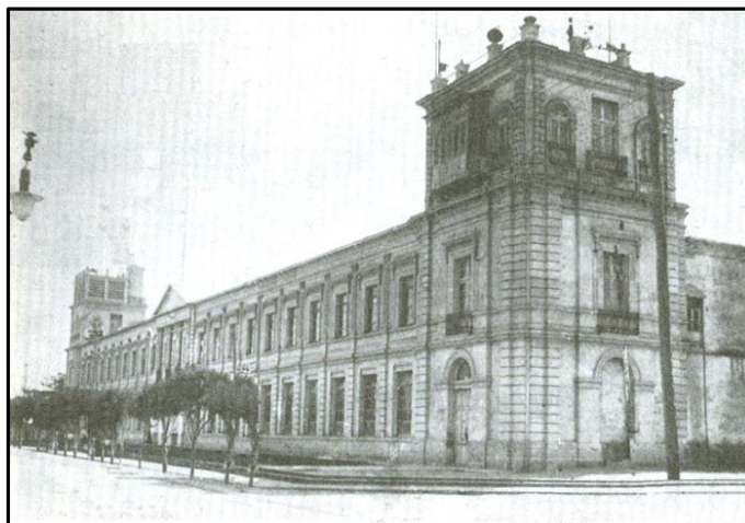
Edificio de Rectoría anterior a 1928. En 1928, el 4 de marzo fue colocada la primera piedra del que sería el "Monumento a los Maestros Desaparecidos".(3)
